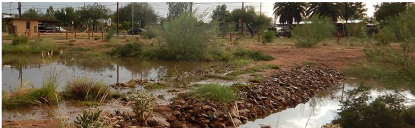
Stormwater Collection Basin (Natural Irrigation) Cuenca para recoger aguas pluviales (riego natural)
